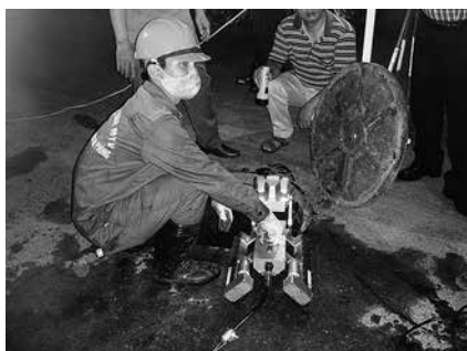
写真-2 もぐりんこをマンホールに挿入するSADCO技術者
