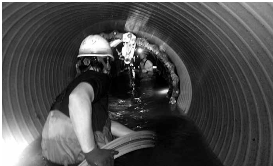
写真-1 管路更生工法の施工状況（ベトナム・ホーチミン市）
