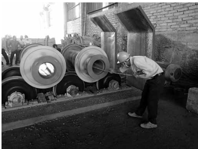
写真-1 推進管製造状況
