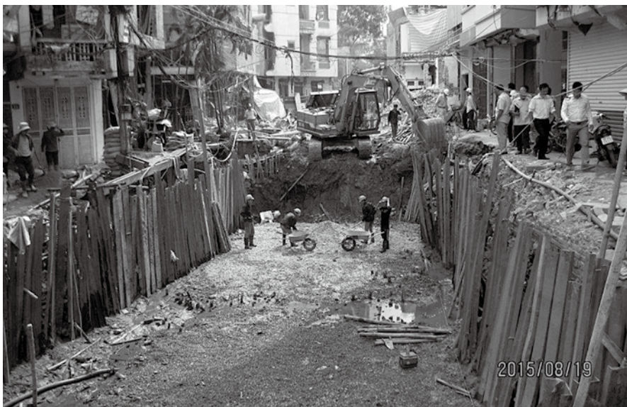
写真-1 市街地での開削工事
