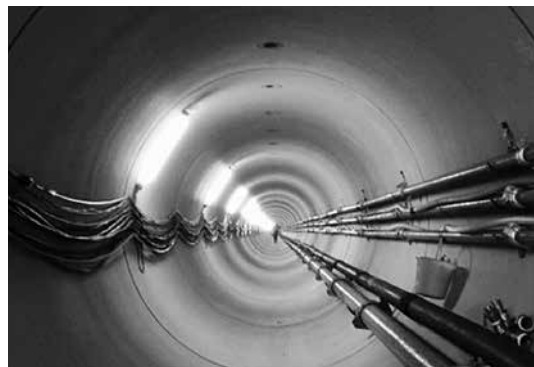
写真-1 鉄筋コンクリート管内
