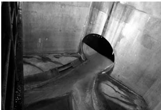
写真-2 マンホール内の状況
