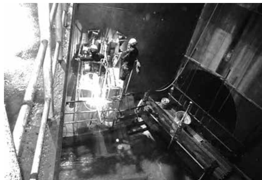
写真-3 コア抜き作業床
