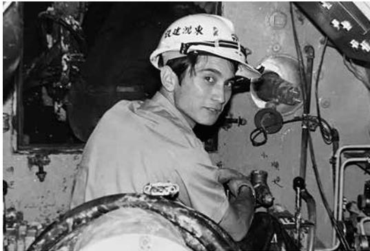
写真-2 リモコン圧気掘進機を操作する機動の職員
