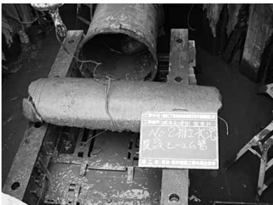
写真-2 障害物切断回収（既設管）
