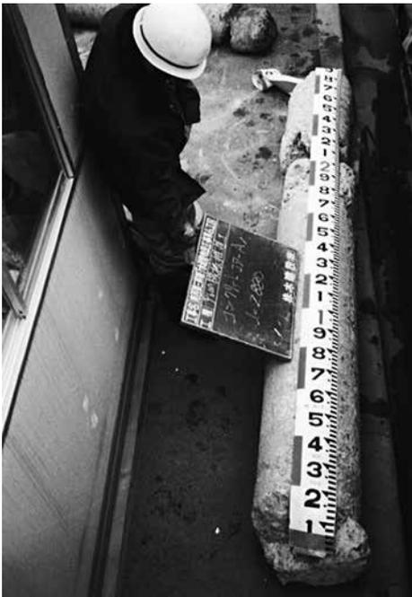
写真-1 障害物切断回収（橋脚基礎）
