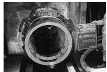
写真-4 鋼開口調整装置設置状況
