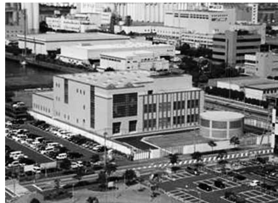
写真-3 中央雨水ポンプ場
