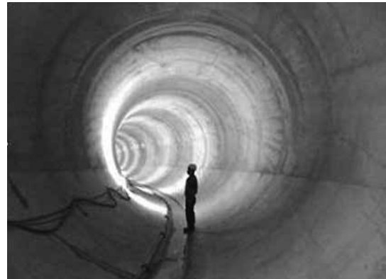
写真-2 中央雨水1号貯留幹線
