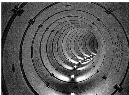
写真-1 目地開きストップの使用状況
