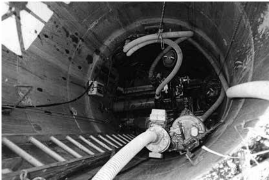
写真-1 スピーダーパス立坑内施工写真
