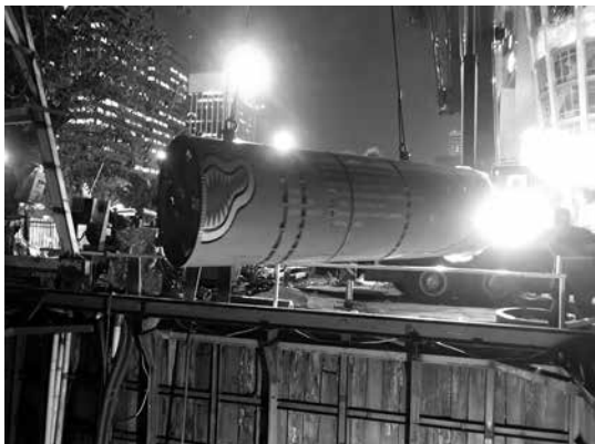
写真-1 掘進機吊り降ろし状況
