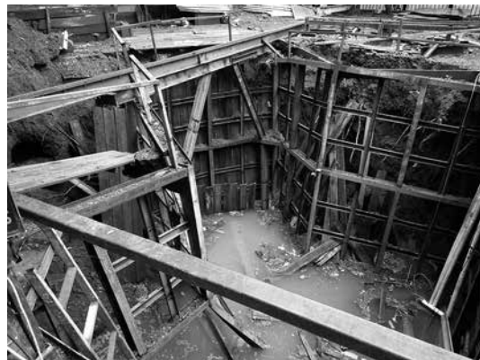
写真-3 JICA工事立坑崩落
