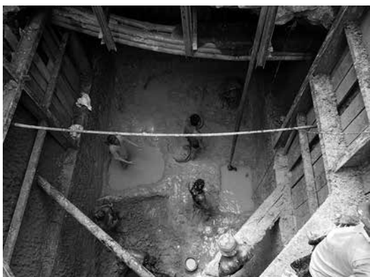
写真-2 人力立坑掘削
