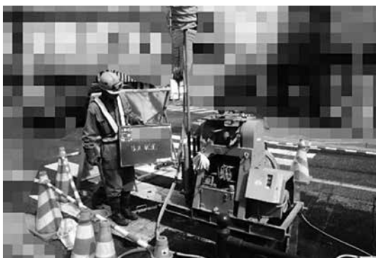
写真-1 二重管ストレーナ工法の施工
