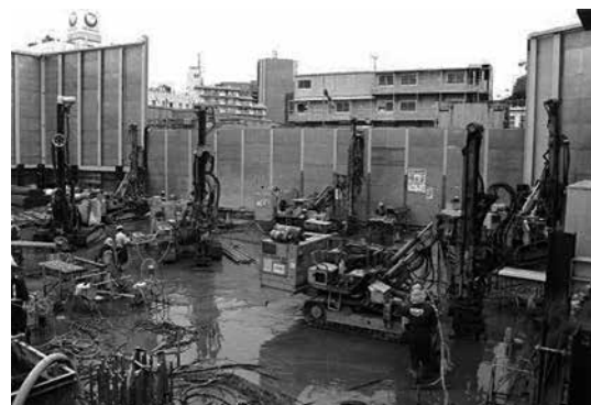
写真-2 ダブルパッカー工法の施工
