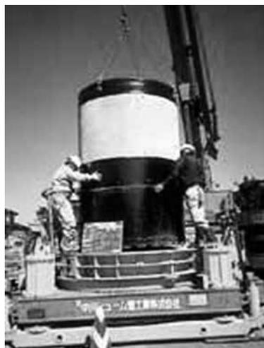
写真-3 刃口、側塊設置<sup>3)</sup>
