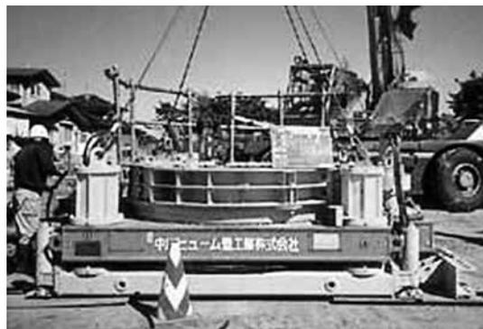
写真-2 圧入機据付設置<sup>3)</sup>
