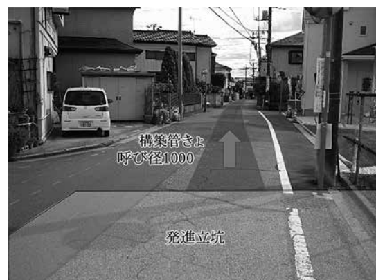
写真-1 工事箇所（発進立坑～到達）
