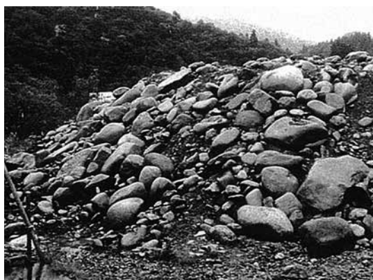
写真-2 立坑掘削残土の状況
