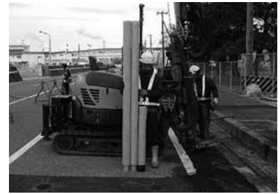
写真-4 埋設ドレーン材
