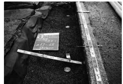
写真-5 ドレーン埋設後
