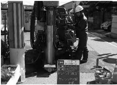
写真-2 ケーシング打設工
