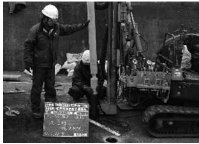
写真-3 ドレーン挿入状況
