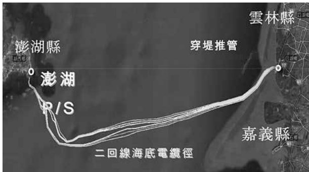
写真-1 工事全容
