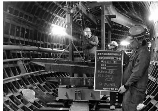
写真-1 枕木用鋼材吊下ろし状況
