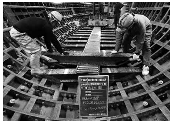
写真-2 運搬・設置状況
