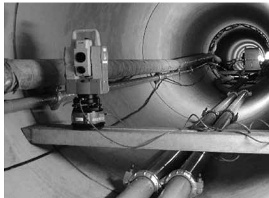
写真-2 管内設置状況
