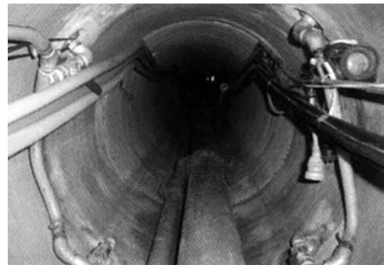
写真-5 管内設備
