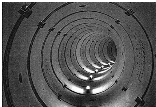
写真-2 目地開口抑制装置使用例
