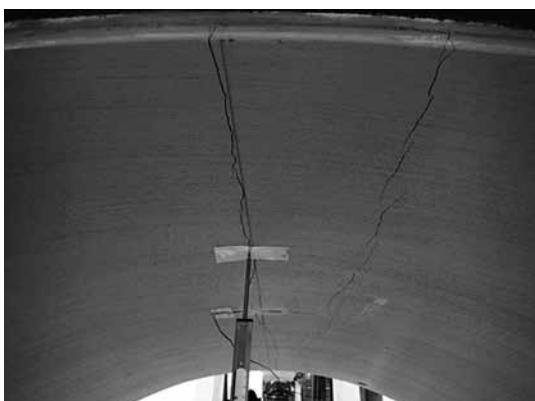
写真-4 MAX推進管の破壊試験状況（試験終了時）
