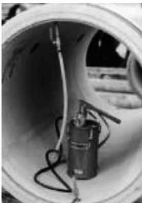
写真-1 注入ポンプ取付け例
