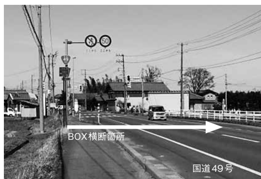
写真-1 現場状況
