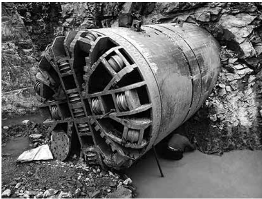
写真-1 岩盤での到達状況
