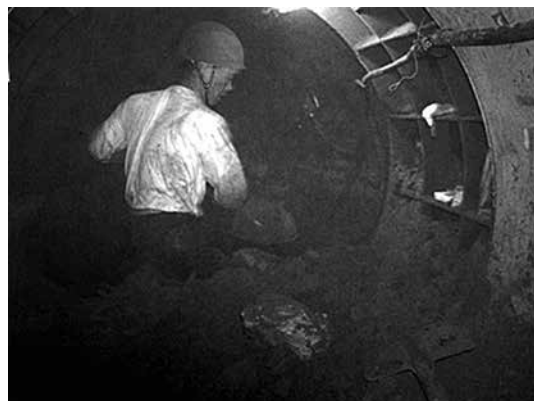
写真-1 刃口式推進工法の人力による掘削の様子
