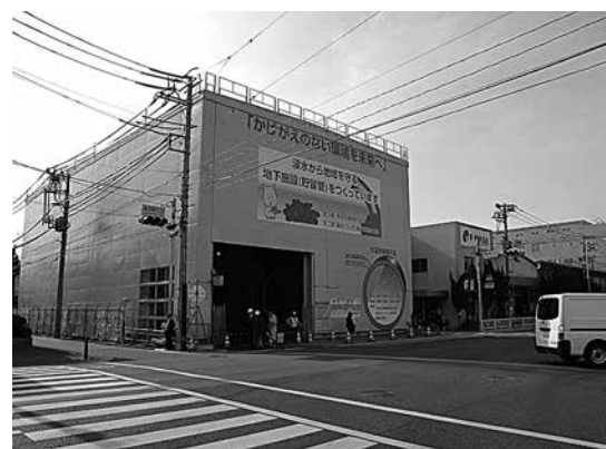
写真-2 超大口径管推進による雨水貯留管敷設工事
